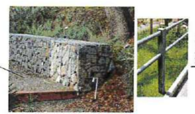
Atraminė sienutė(gabionas) su apsaugine tvorele bendrai h-1.20m
