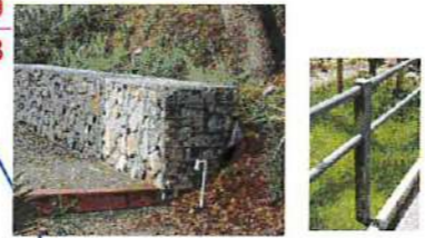
Atraminė sienutė (gabionas) su apsaugine tvorele bendrai h-1.20m
